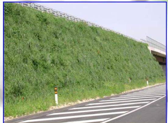
**Foto 3 – Beispiel für die begrünten Bewehrten Erden zur Errichtung einer Straßenböschung**
