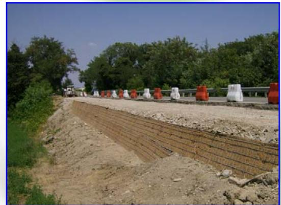
**Foto 2 – Beispiel in der Realisierungsphase zur Verbreiterung einer Straße mit talseitiger Konsolidierung**
